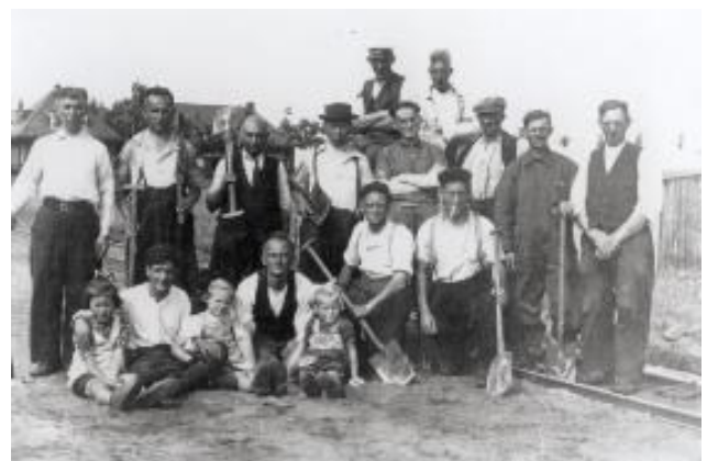
Joodse arbeiders aan het werk in kamp De Beetse Foto's: www.joodsewerkkampen.nl
