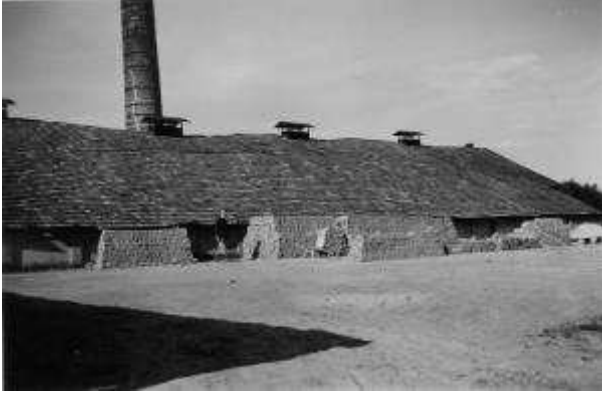
Ringoven van buiten gezien. Op de voorgrond het tasveld met gebakken stenen.
