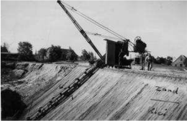
Bagger in bedrijf. De pijlen geven aan hoe de transportband met de kleibakken naar beneden en naar boven gaat.
